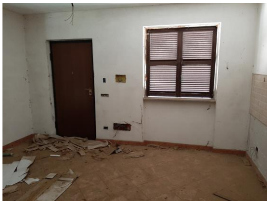
Immagine 9 – Vista piano terra
