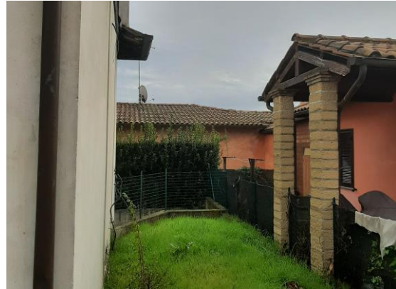
Immagine 2 – Vista retro dell'edificio e zona portico mancante
