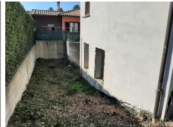
Immagine 4 – Vista rampa accesso all'interrato da eseguire
