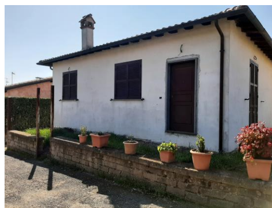
Immagine 12 – Vista esterna del fabbricato lato strada
